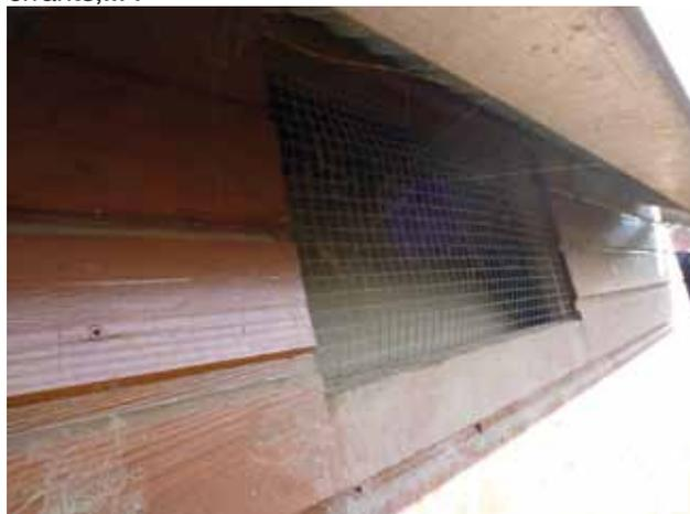
*Grillage sur les entrées d'air permettant l'aération sans intrusion d'oiseaux extérieurs*
