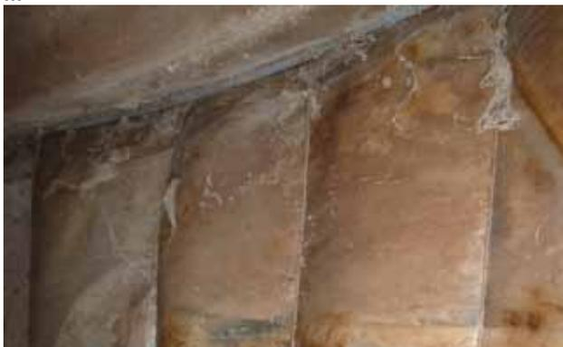
Isolation d'un tunnel avec de la laine de verre inséré entre 2 bâches
